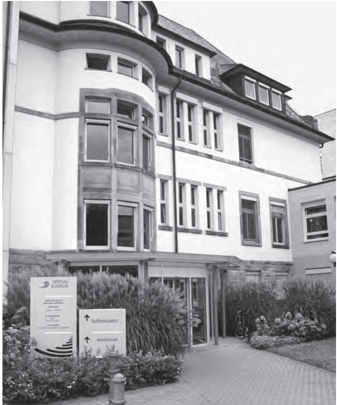
Blick auf Altbau- Treppenhaus. Foto: Ruch
