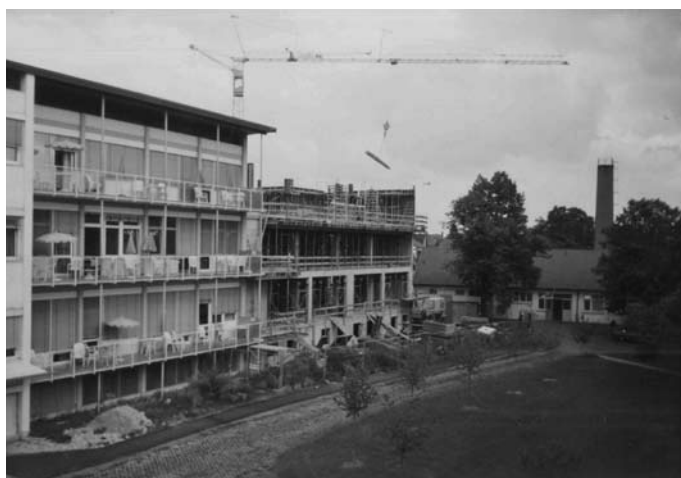
Bau des neuen Ostflügels
